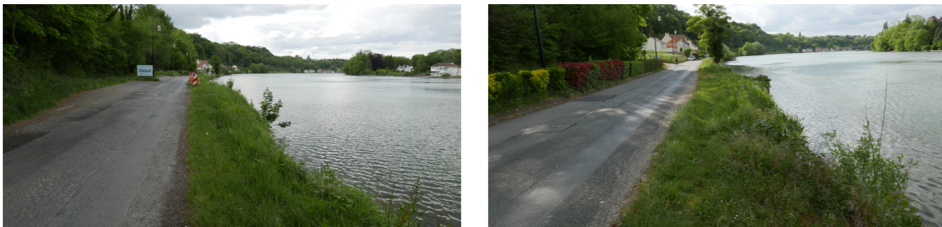
Figure 12 Illustration de la pauvreté de la ripsisylve des bords de Seine sur les tronçons 1 à 3 (Clichés Biotec - 28/04/2020).
